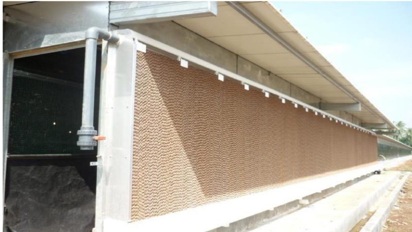
Gambar 7. Pipa penampung kotoran air
